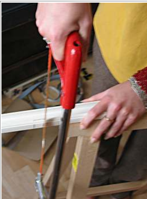
1 - Se placer sur un support stable (tréteau), bien tenir la goulotte.
