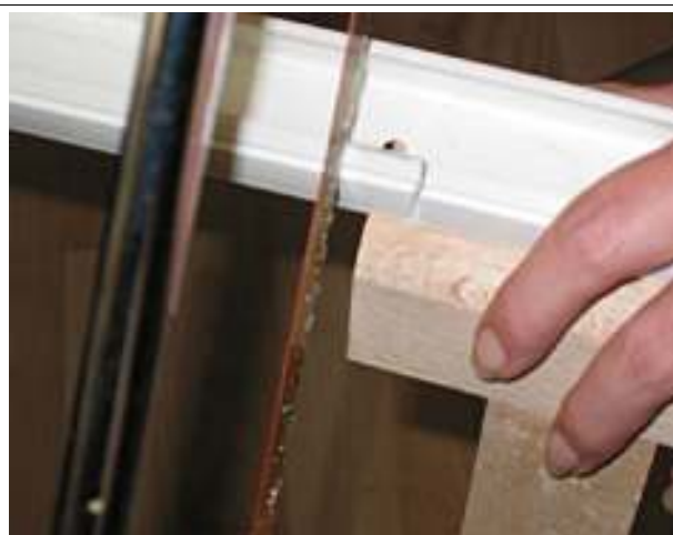
2 - Scier précautionneusement le côté de la goulotte, aux endroits marqué, sans abîmer le grand côté qui sera visible.
